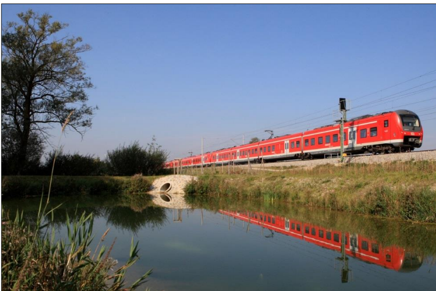
Umweltschutz genießt bei der Deutsche Bahn einen hohen Stellenwert. Abwasser wird in vielen Stellwerken vollbiologisch aufbereitet.
